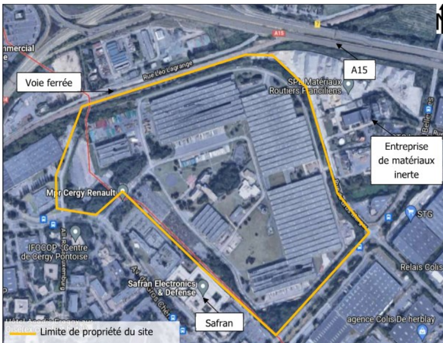
Vue aérienne su site et de son environnement
